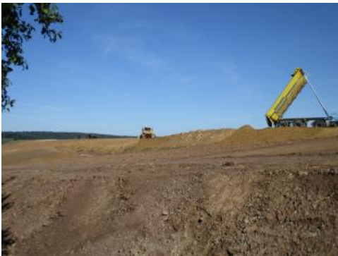
Umfangreicher Massenauftrag bei einer Rebflurneuordnung im Sommer 2024 im Landkreis Heilbronn (Foto: Flurneuordnungsamt Heilbronn)
