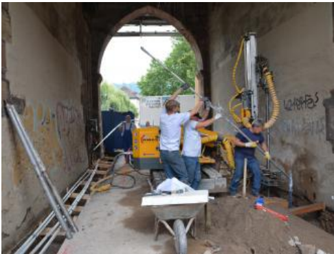
Einführen der Injektionslanzen während der Sanierung des Freiburger Schwabentors (Foto: Fa. Uretek)
