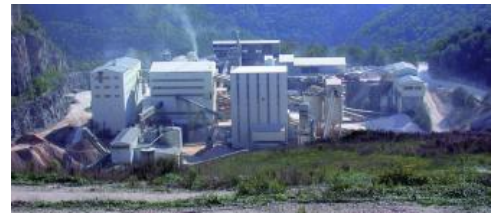
Aufbereitung in einem Kalksteinbruch auf der Schwäbischen Alb
