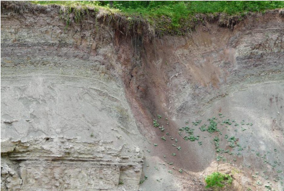
Karstschlotte an der Abbauwand des Gipsbruchs nördlich von Saurach
