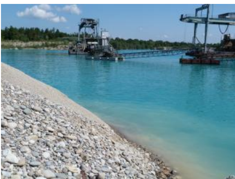
Nassabbau von Kies mit dem Schwimmbagger
