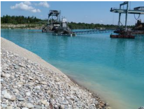
Nassabbau von Kies mit dem Schwimmbagger
