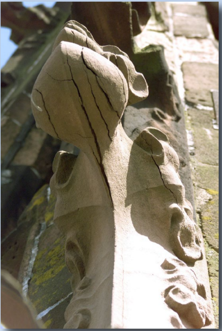
◀ Abb. 4: Starke Schäden an einer „Krabbe“ aus feinkörnigem, tonig gebundenem Plattensandstein am Turmhelm des Freiburger Münsters. Die Risse folgen der mit bloßem Auge kaum erkennbaren Schichtung. Die Krabbe war erst in den 1960er Jahren unter Verwendung von Freudenstädter Plattensandstein erneuert worden. (Foto: Münsterbauverein, 2002).
