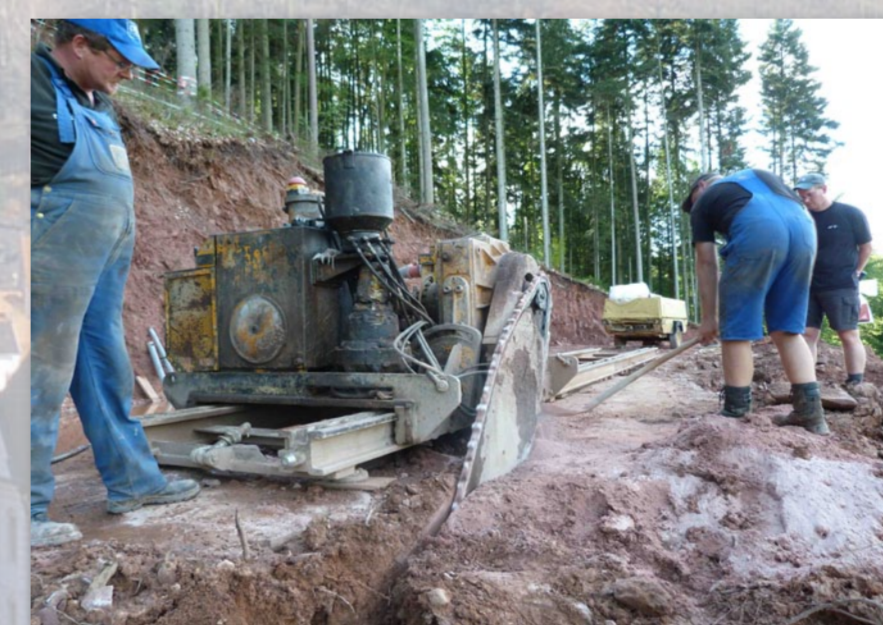
◀ Abb. 11: Probeschnitt mit der Schwertsäge, August 2012; wegen des hohen Geröllanteils erwies sich diese Methode in den Abraumschichten als nicht geeignet.
