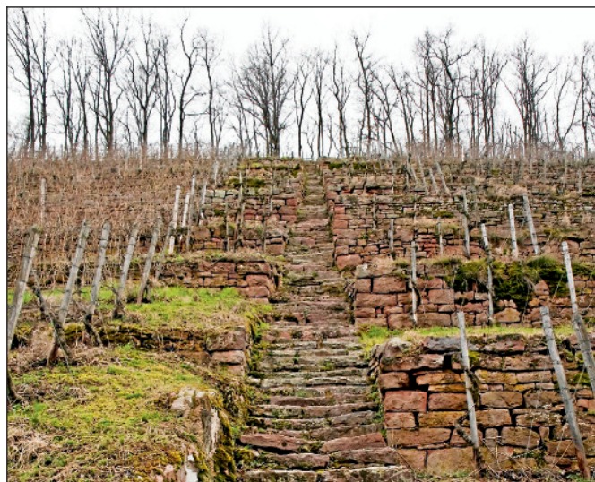
Alte Mauern und Treppen sind überall im Taubertal zu sehen, mit Wein bestockte alte Terrassen jedoch nur noch am Satzenberg bei Reicholzheim. Bilder (6): Achtziger
