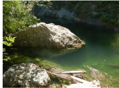
Aufgestaute Eschach im Oberstrom des Schadensbereichs
