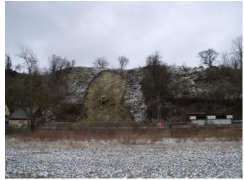
Rutschung (Entstehung 2006) im Bereich der Oberen Meeresmolasse, Sipplingen
