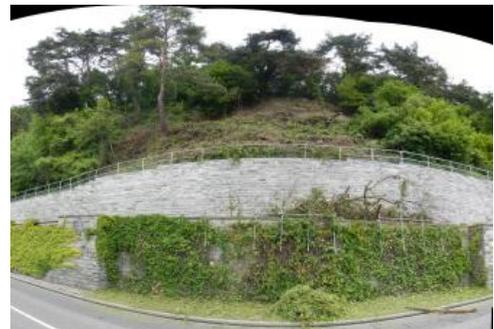
*2016 entstandene, sekundäre Rutschung am Radweg bei Sipplingen*
