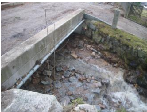
Kleine Brücke am Schwarzenbachweg über den Oberen Großbach nach Beseitigung der Verklausung
