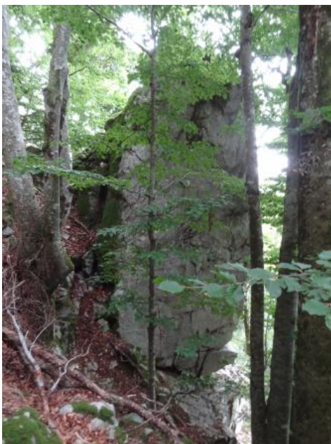
Zu sichernder Felsturm (Gefährdungspunkt G031) mit durchtrenntem, hangauswärts fallendem und vorbewegtem Fußbereich
