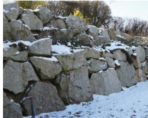
Rohblöcke aus Albtal-Granit als Sützmauer
