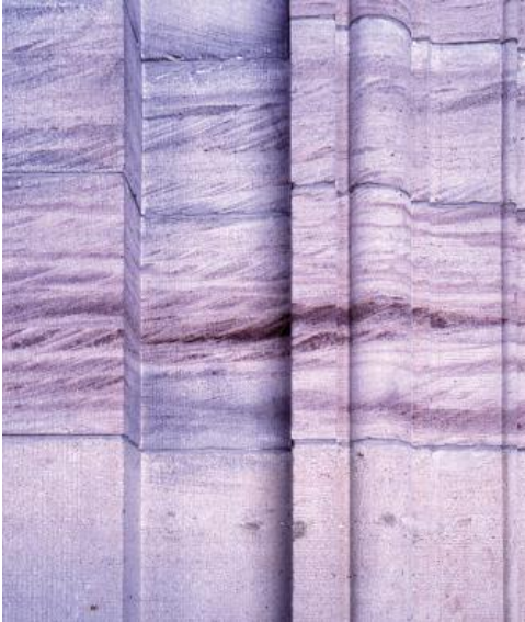
Mauerwerk des Portalgebäudes des Doms in St. Blasien
