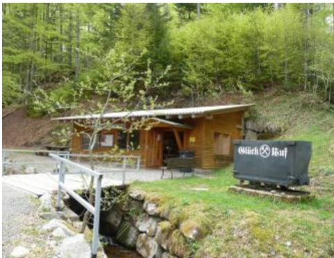
Grubenhütte am Besucherbergwerk Hoffnungsstollen in Todtmoos
