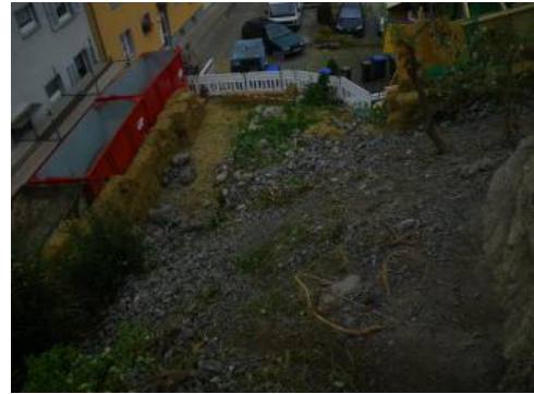
Ausbildung eines Sturzraumes als Sofortmaßnahme
