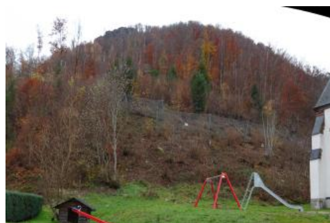
Steinschlagschutzzaun oberhalb der Kirche von Todtnau-Geschwend
