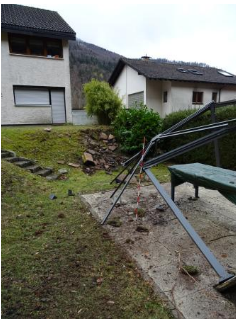
Zerstörter Pavillon und Grill in einem Garten der Gisibodenstraße
