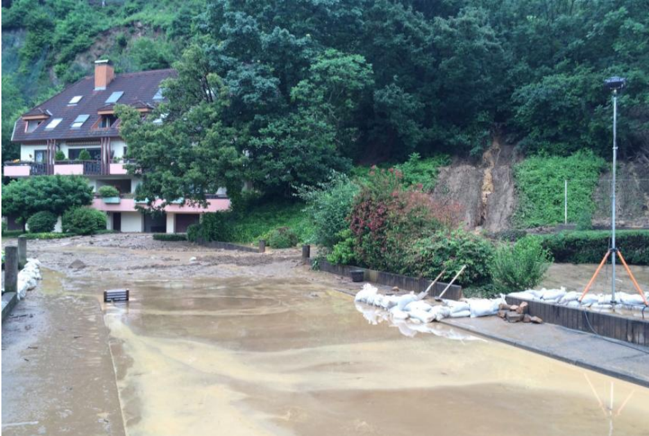
Straße Unteres Amtsfeld in Waldkirch nach dem Murgang vom 13.06.2016 (Foto: Feuerwehr Waldkirch)
