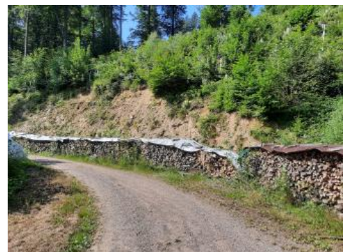
Ansicht des Oberen Galgenwegs nach bergseitiger Wegverlegung und Instandsetzung
