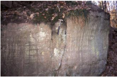
Hauptbank in den aufgelassenen Steinbrüchen bei Degerfelden
