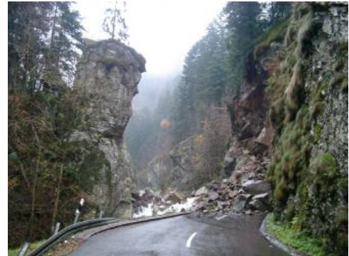
Sturzmassen auf der L 148, Lkr. Waldshut
