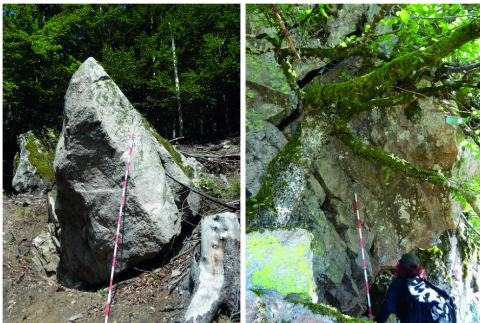
Akut absturzgefährdete Felsblöcke
