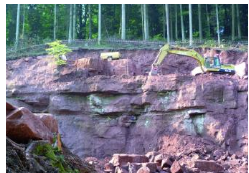
Bohren und Schneiden mit einer Seilsäge
