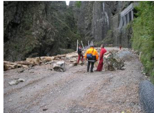
B31 während der Räumarbeiten
