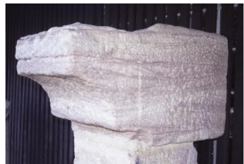
Balkenwiderlager aus grobkörnigem, schräg geschichtetem Degerfelder Sandstein
