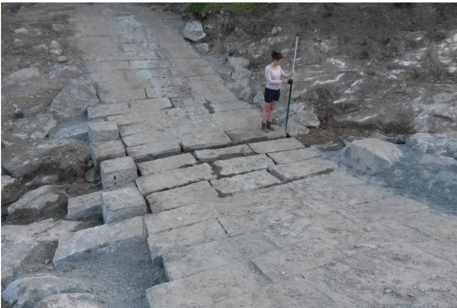
Ersetzen der Brücke am Schwarzenbachweg durch eine Furt (Foto: Stadt St. Blasien)
