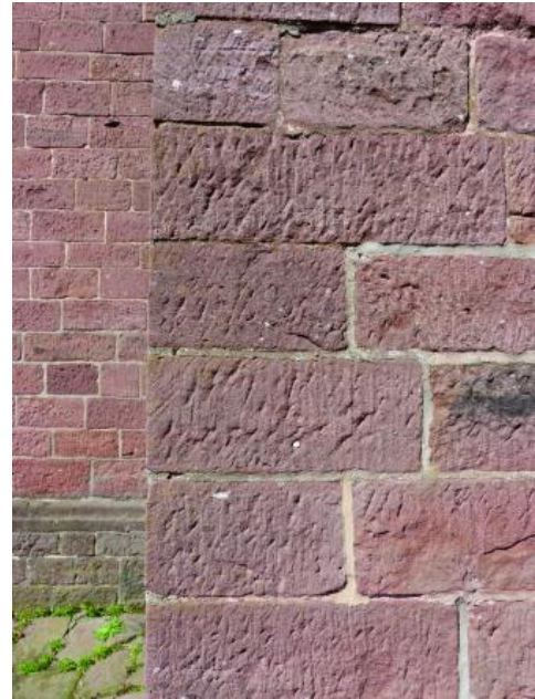
Mauerwerk der evangelischen Kirche in Freiamt-Mußbach aus geröllführendem Sandstein
