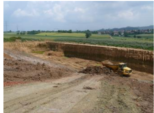
Abbau von Löss und Lösslehm
