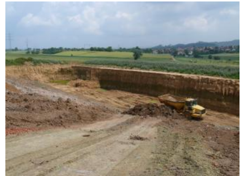
Abbau von Löss und Lösslehm
