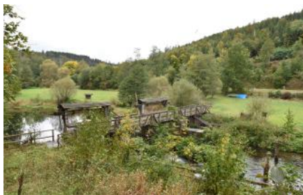
Talaue der Nagold bei Altensteig mit der rekonstruierten Monhardtter Wasserstube aus der Flößerzeit
