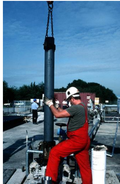
Pumpeneinbau in eine Tiefbohrung, hier: Bruchsal (Foto: Stober & Bucher, 2014)
