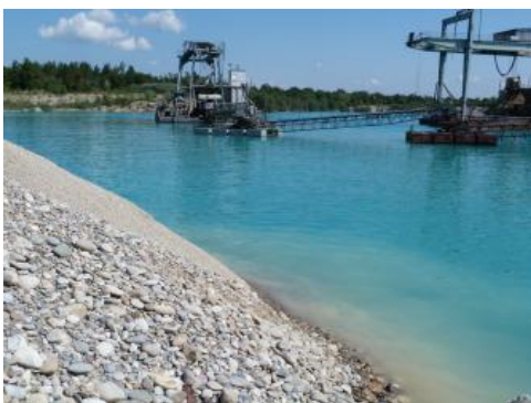
Nassabbau von Kies mit dem Schwimmbagger
