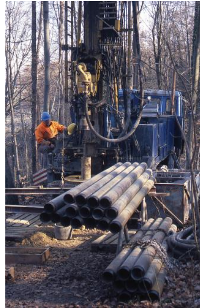
Erkundungsbohrung, durchgeführt 2010 oberhalb des östlichen Steinbruchs
