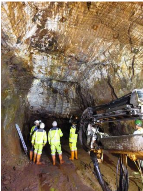
Unter-Tage-Aufnahme aus der Grube Clara mit verzerrem Diagonaltrum
