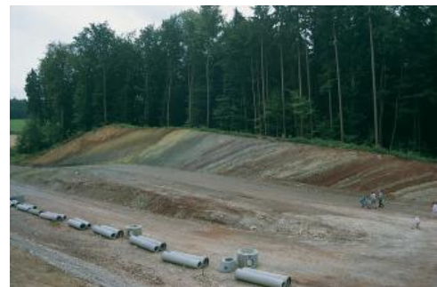
Autobahnbaustelle östlich von Hagenbach mit schräggestellten Keuper und Unterjuraschichten
