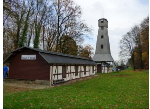
Sole aus Bad Rappenau für den Bäderbetrieb
