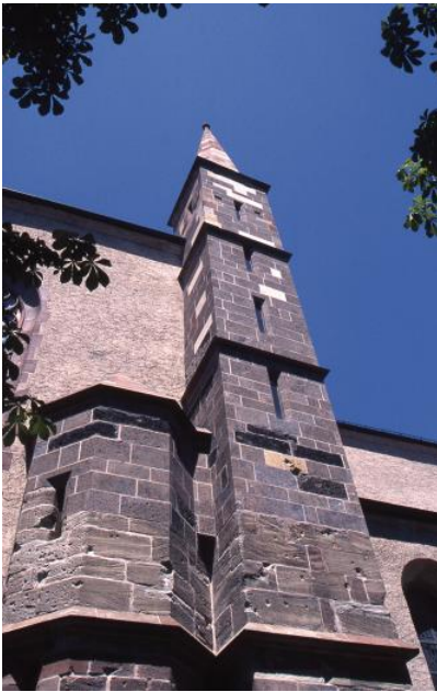
Treppenturm des Breisacher Münsters
