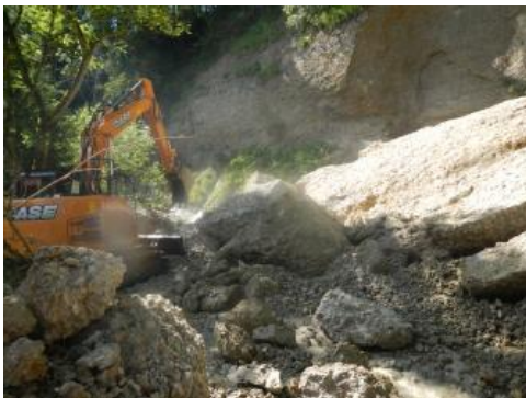
Bagger beim Beräumen des Bachbettes
