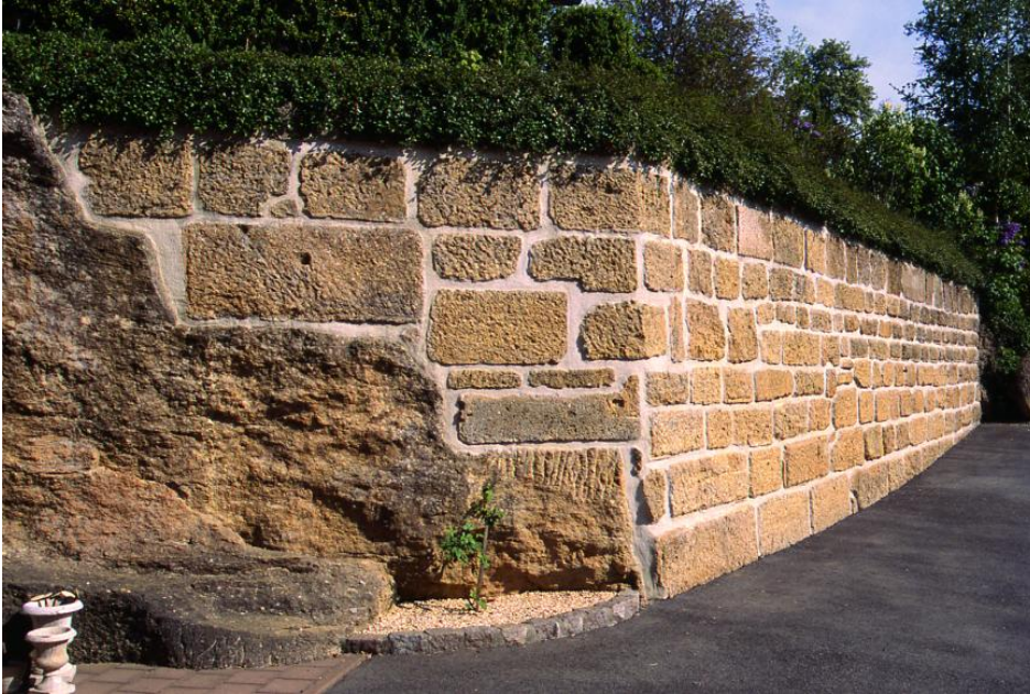
Gartenmauer aus Randengrobkalkquadern
