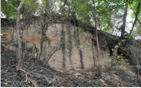
Lösswand in einem Hohlweg südöstlich von Buggingen
