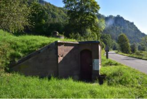
Quellfassung Langenbrunnen Werenwag, Hausen im Tal
