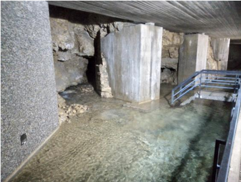
Quellsammelschacht der Quellen Neidinger Mühle Ost, Mitte und West (Talmühlequelle), Unterneidingen
