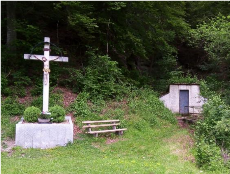
Fassungsbauwerk der Quellfassung Lochbrunnen im Burtelbachtal östlich von Unterdigisheim
