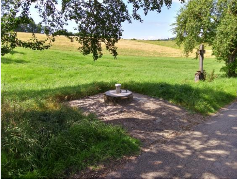
Quellsammelschacht der Oberen Schlauchquellen, Riedöschingen
