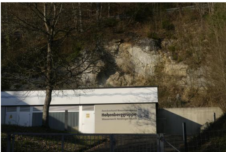
Das Wasserwerk Neidinger Mühle des Zweckverbandes Wasserversorgung Hohenberggruppe wurde Anfang der 2010er Jahre außer Betrieb genommen. Die aus dem Jahr 1974 stammende Anlage soll jedoch zur Deckung des gestiegenen Wasserbedarfs der Verbandsgemeinden wieder reaktiviert werden.
