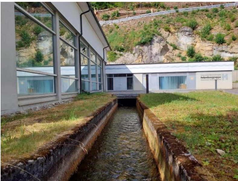
Abfluss der Talmühlequelle über einen gemauerten Kanal auf dem Gelände des Wasserwerks des Zweckverbandes Wasserversorgung Hohenberggruppe.
