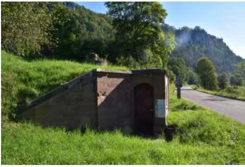
Quellfassung Langenbrunnen Werenwag, Hausen im Tal
