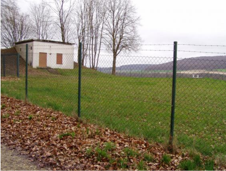
Brunnen Zwiefaltendorf: Fassungsbauwerk im umzäunten Fassungsbereich (Wasserschutzgebietszone 1)
