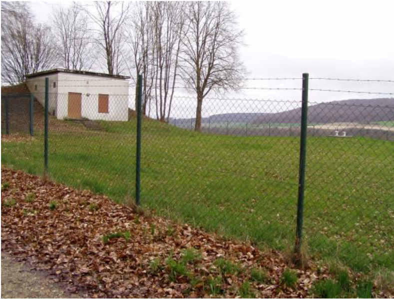
Brunnen Zwiefaltendorf: Fassungsbauwerk im umzäunten Fassungsbereich (Wasserschutzgebietszone 1)
