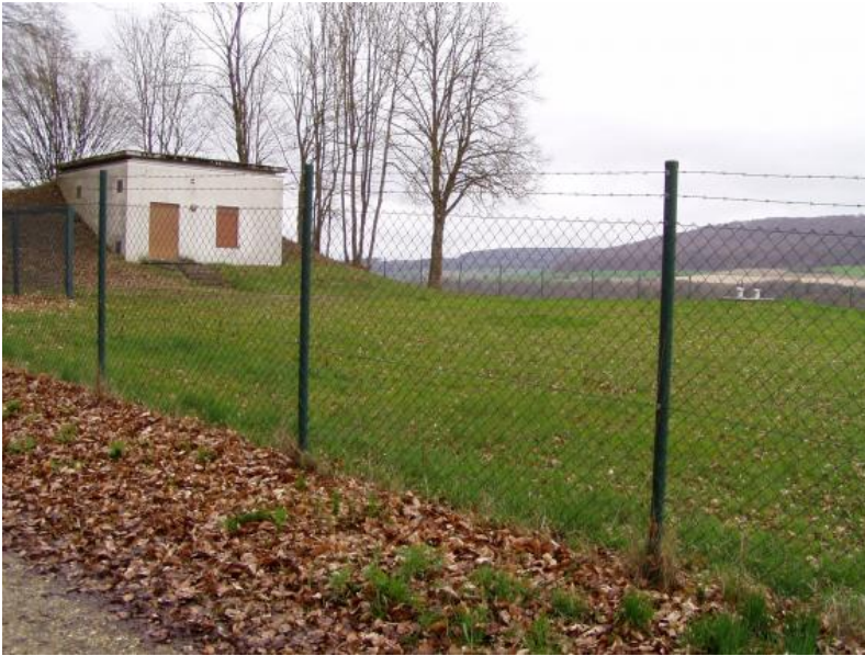
Brunnen Zwiefaltendorf: Fassungsbauwerk im umzäunten Fassungsbereich (Wasserschutzgebietszone 1)
