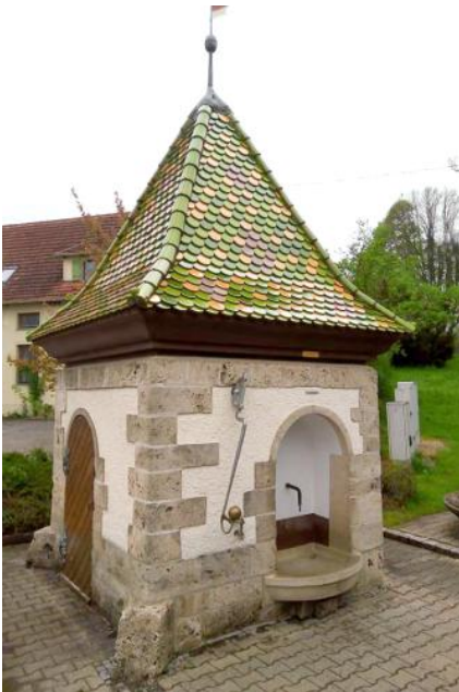
Der Mineralwassersäuerling von Kleinengstingen wurde in einem 4,5 Meter tiefen Schachtbrunnen gefasst und mit einem Brunnenhäuschen überbaut.
