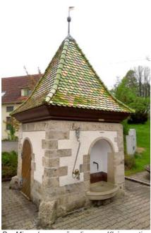
Der Mineralwassersäuerling von Kleinengstingen wurde in einem 4,5 Meter tiefen Schachtbrunnen gefasst und mit einem Brunnenhäuschen überbaut.
