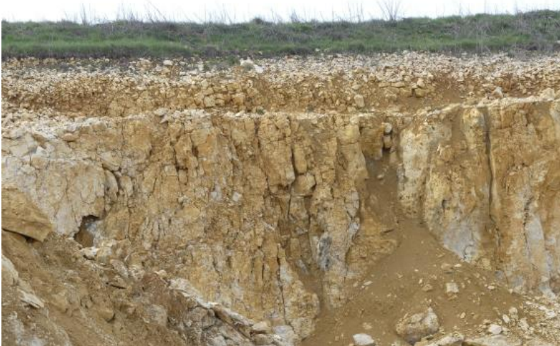
Der oberflächennahe Epikarst folgt unter der geringmächtigen Bodenzone. Er wirkt vermutlich als oberflächennaher Speicherhorizont und wird von stark geklüftetem und verkarstetem Karbonatgestein unterlagert. (Steinbruch Buchheim)
