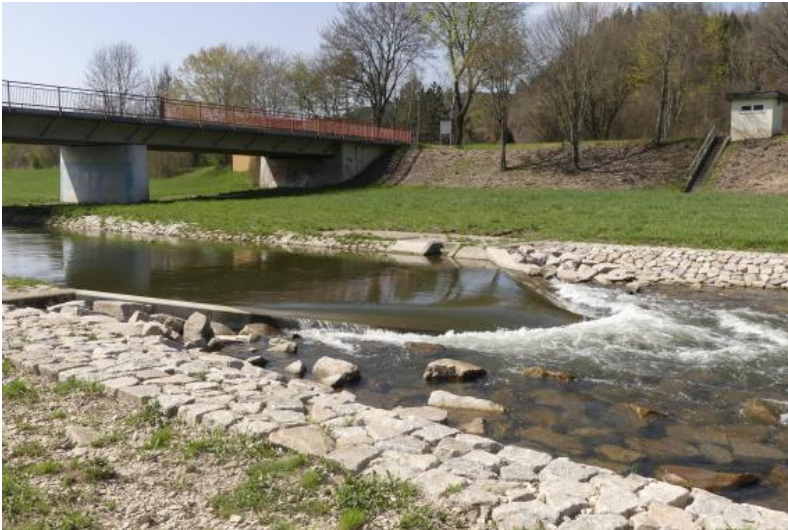
Pegel an einem Oberflächengewässer: Donaubrücke bei Tuttlingen-Möhringen
