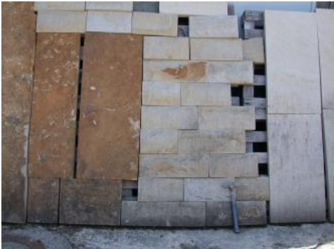
Farblich erkennbare Varietät der Gesteinsplatten aus Sandstein
