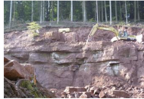
Abräumen im Steinbruch am Langauweg, westlich von Tennenbach
