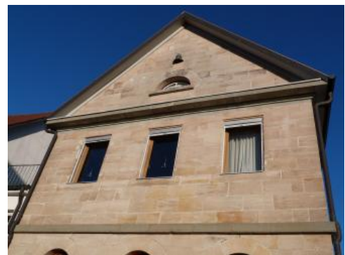
Mauersteine eines Wohnhauses aus Stubensandstein
