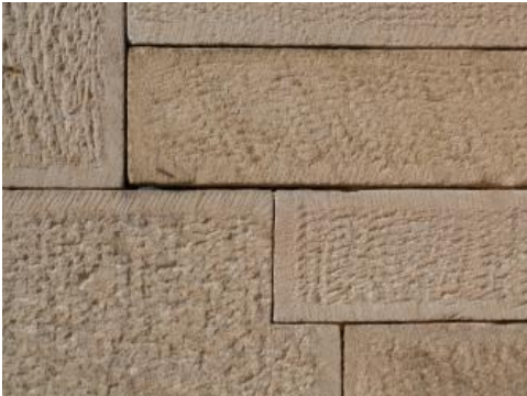
Mauerwerk aus Stubensandstein
