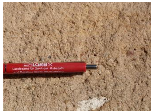
Detailaufnahme des Stubensandsteins aus dem Mauerwerk des Kirchengebäudes der katholischen Kirche St. Markus in Geislingen-Binsdorf.
