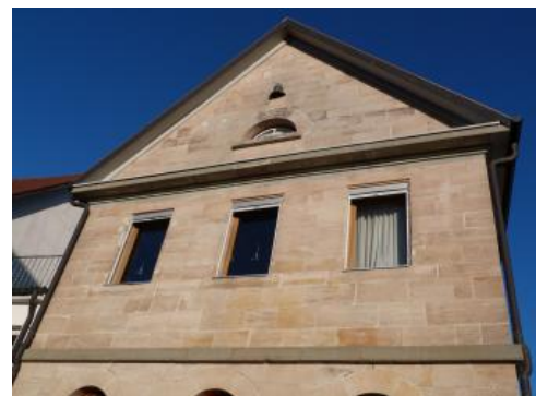
Mauersteine eines Wohnhauses aus Stubensandstein
