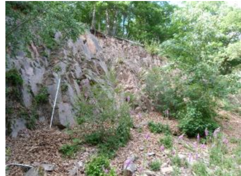
Aufschluss des Kienbach-Granits mit engständiger Klüftung
