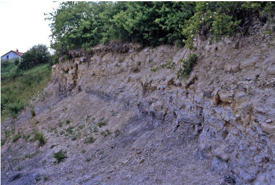
Inhomogenes Verwitterungsprofil mit Wechsel aus feinkörnigen und grobkörnigen Bestandteilen an einem Böschungsaufschluss der Amaltheenton-Formation
