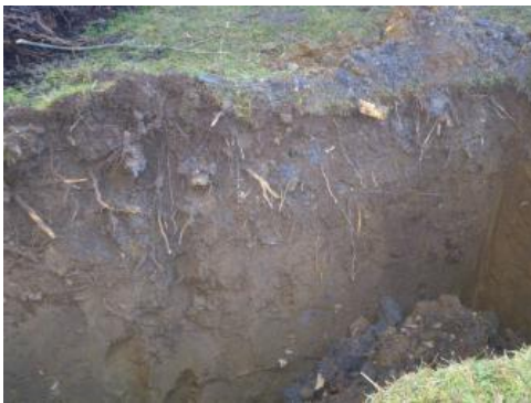
Starke Durchwurzelung in Schurf 1
