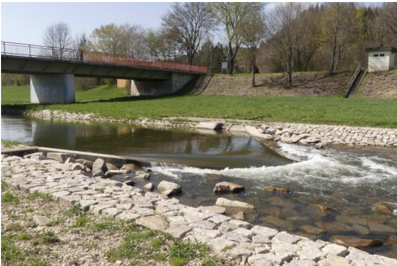
Pegel an einem Oberflächengewässer: Donaubrücke bei Tuttlingen-Möhringen
