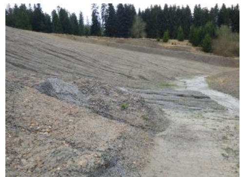
Schräggabbau der stark schluffigen Tonsteine der Obtususton-Formation.
