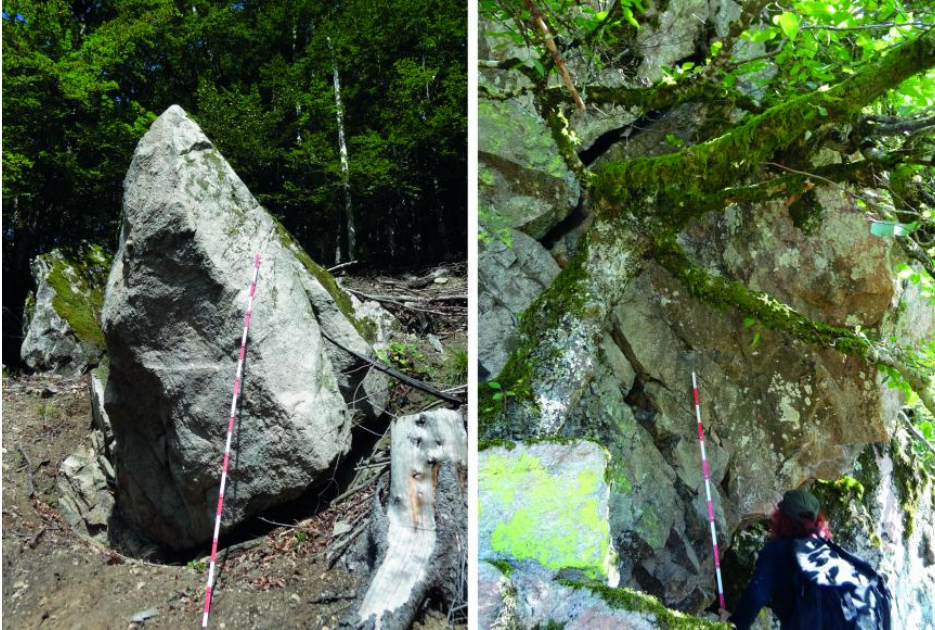
Akut absturzgefährdete Felsblöcke
