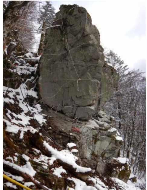
Gefährdungspunkt G031 mit Stahlseiltrossen als Vorsicherung
