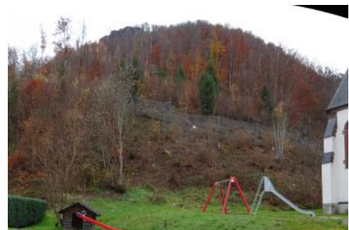
Steinschlagschutzzaun oberhalb der Kirche von Todtnau-Geschwend
