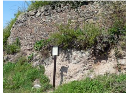
Geologischer Weinlehrpfad Achkarren – Station Stützmauer über Lavastrom
