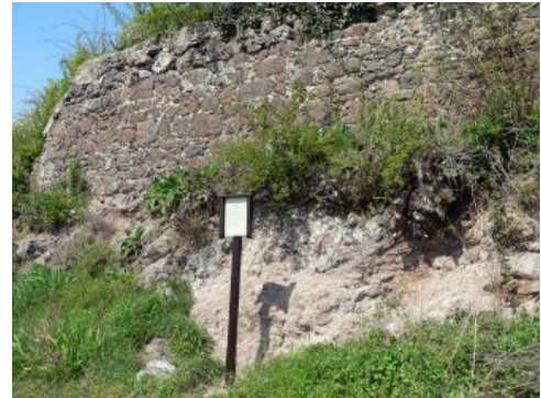
Geologischer Weinlehrpfad Achkarren – Station Stützmauer über Lavaström
