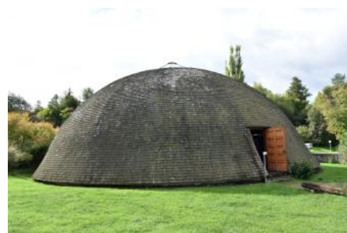
Der heute als Ausstellungsraum genutzte Holz-Rundbau im Salinenmuseum Rottweil stand früher über einem der Sole-Speicherbecken.
