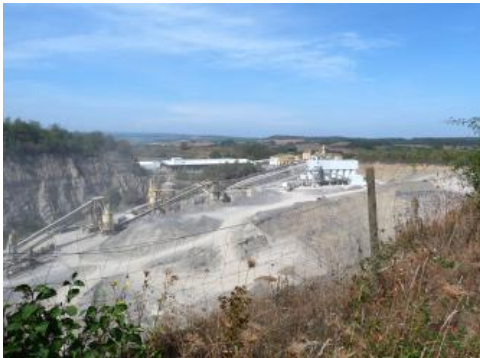
Aufbereitungsanlagen für Gesteinskörnungen im Steinbruch Heimsheim
