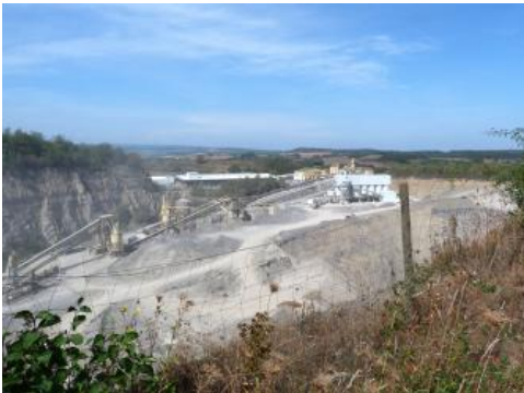
Aufbereitungsanlagen für Gesteinskörnungen im Steinbruch Heimsheim
