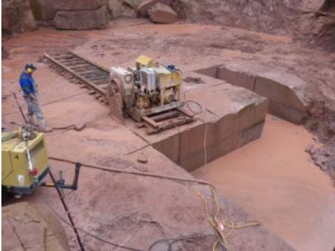
Gewinnung großformatiger, fester Sandsteinblöcke im Steinbruch Tennenbach
