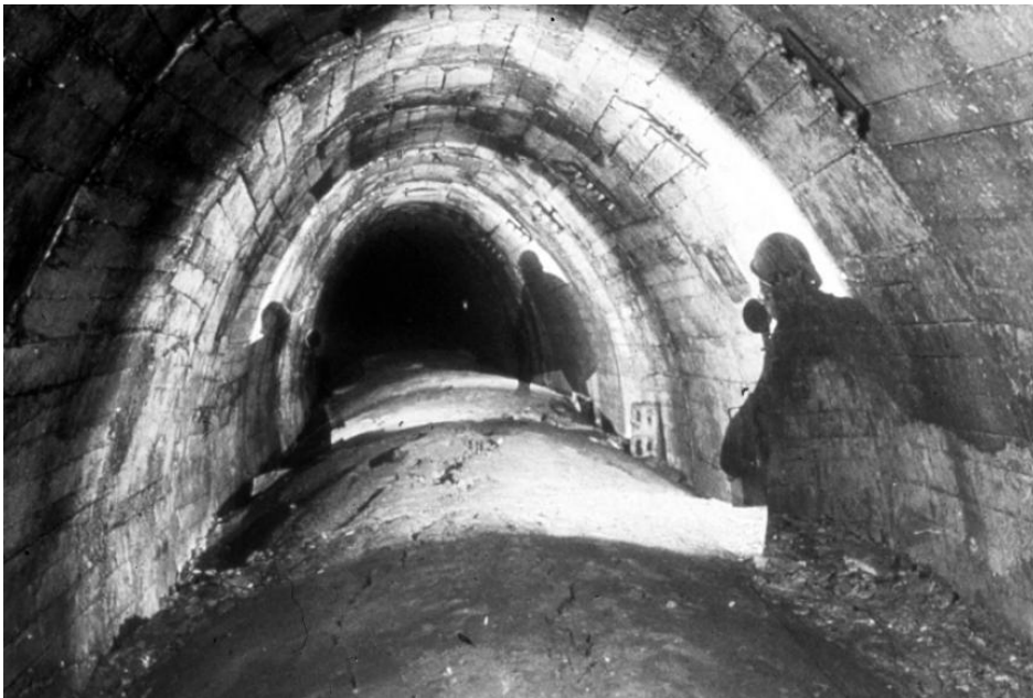
Sohlhebungen im Wagenburgtunnel infolge Anhydritschwellens der Grabfeld-Formation
