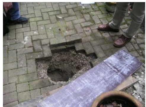
Absenkung infolge von Pseudokarststrukturen
