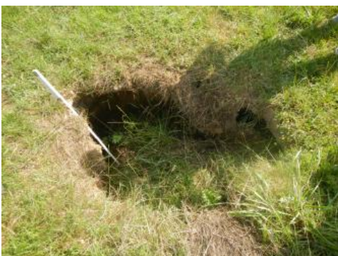
Erdfall auf dem Grundstück der Domäne Hochburg
