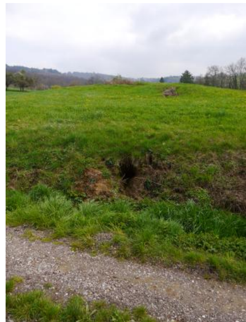
Schwemmkegel mit Austritt eines Suffosionskanals und abgelagertem, feinkörnigem Bodenmaterial
