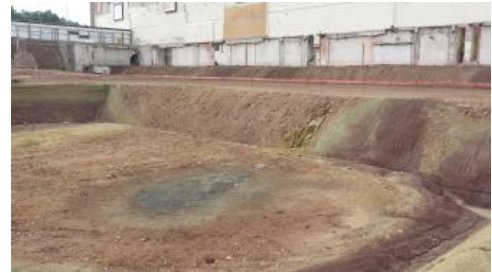
Plombierte Doline in der Baugrube des neuen Stuttgarter Hauptbahnhofs
