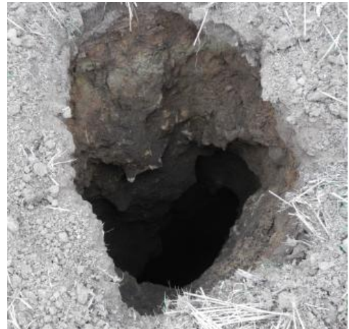
Detailansicht des Erdfalls vom 27.09.2013
