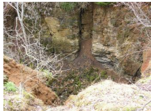
Ansicht der Einsturzdoline bei Göschweiler im Jahr 2005
