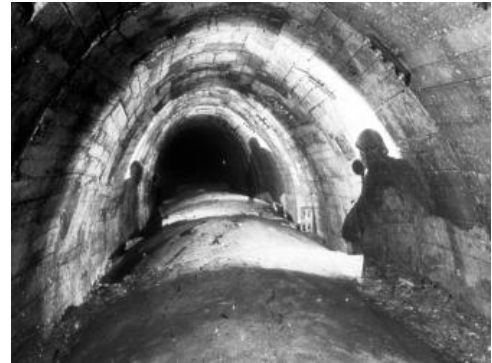
Sohlhebungen im Wagenburgtunnel infolge Anhydritschwellens der Grabfeld-Formation
