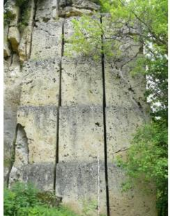
Kalktuffwand mit Abbauspuren durch eine Schrämsäge
