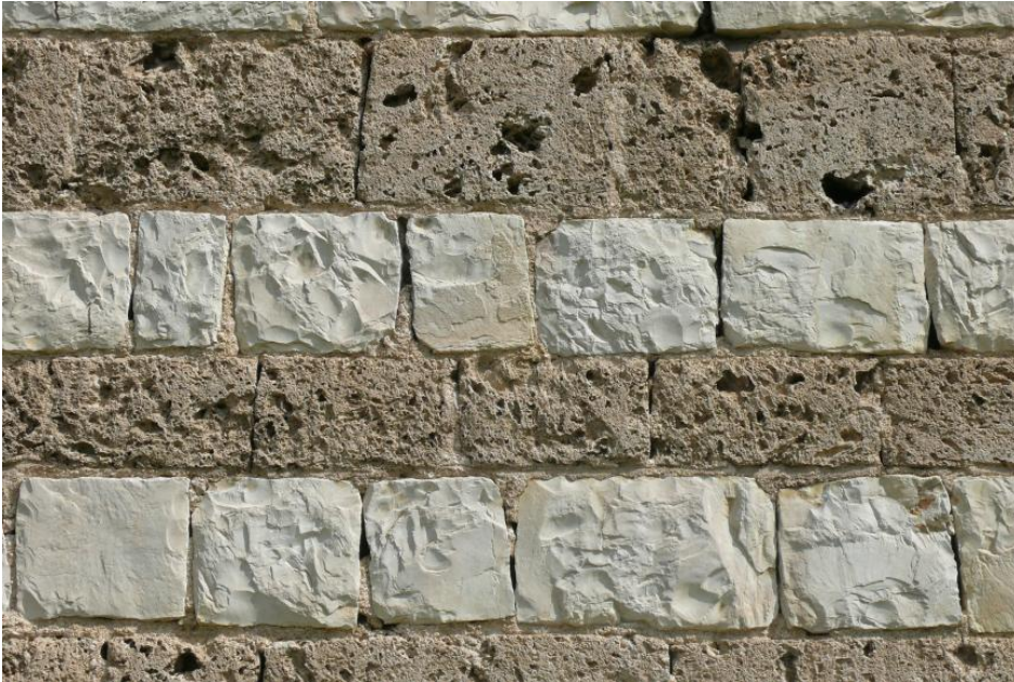
Mauer aus Kalktuffquadern und Bankkalksteinen
