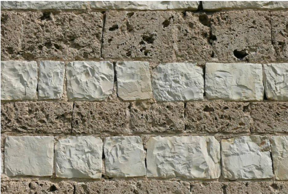
Mauer aus Kalktuffquadern und Bankkalksteinen
