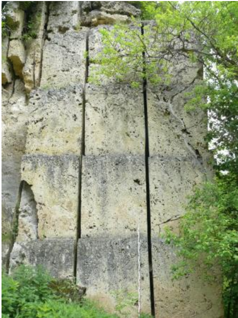
Kalktuffwand mit Abbauspuren durch eine Schrämsäge
