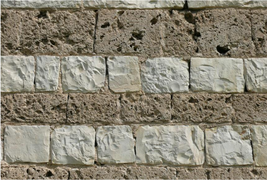
Mauer aus Kalktuffquadern und Bankkalksteinen
