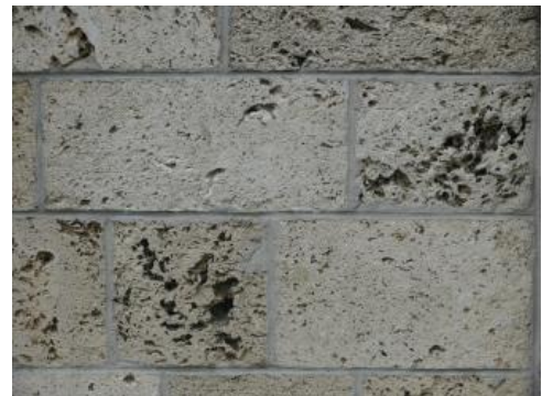
Fassade aus Kalktuffquadern an der Sankt Michaelskirche in Burgfelden
