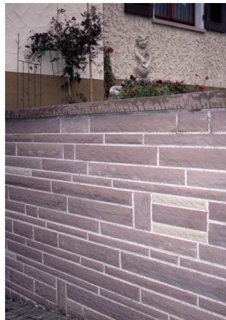
Neue Mauer aus Trichtinger Schilfsandstein, Ortszentrum Trichtingen
