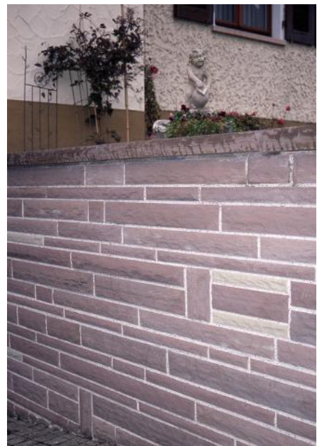
Neue Mauer aus Trichtinger Schilfsandstein, Ortszentrum Trichtingen
