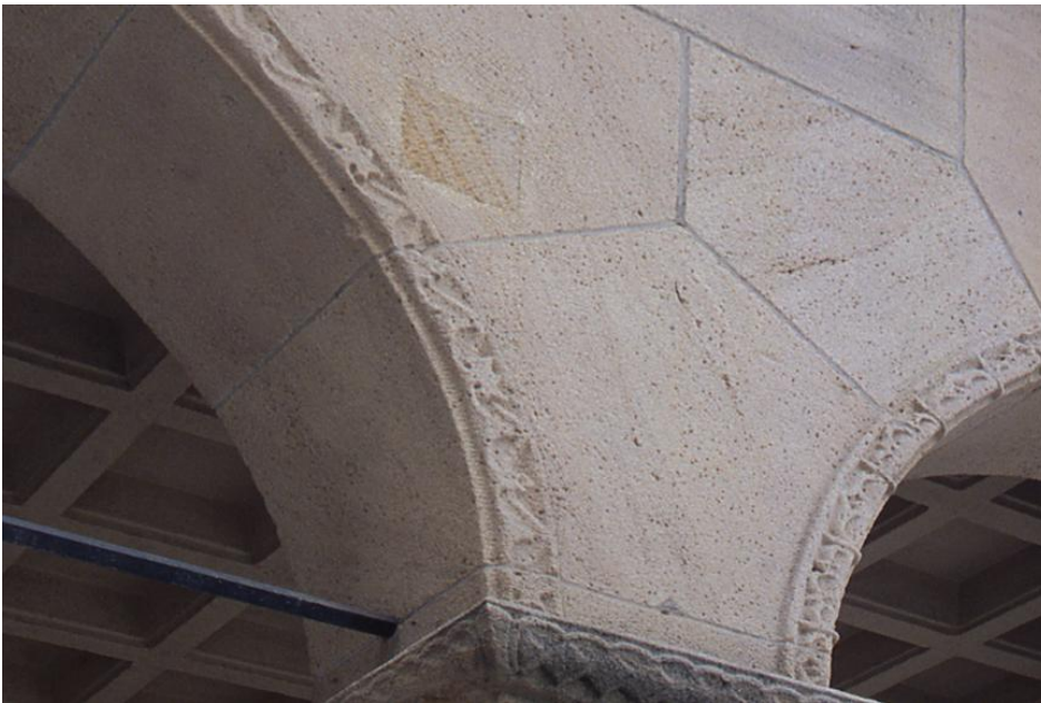
Stubensandstein am Gebäude der Deutschen Bank, Königsstraße Stuttgart
