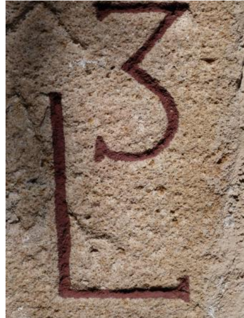
Block aus Stubensandstein an ehem. Mühlegebäude („Neckarburg“) bei Neckartenzlingen
