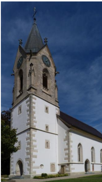
Kirche in Pliezhausen erbaut aus Stubensandstein
