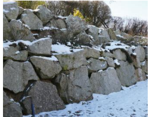
Rohblöcke aus Albtal-Granit als Sützmauer
