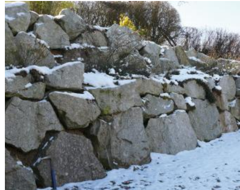
Rohblöcke aus Albtal-Granit als Sützmauer
