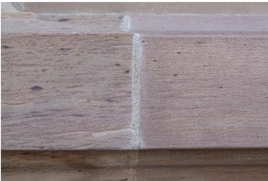
Rot geflammter Schilfsandstein an einer Villa in Heilbronn
