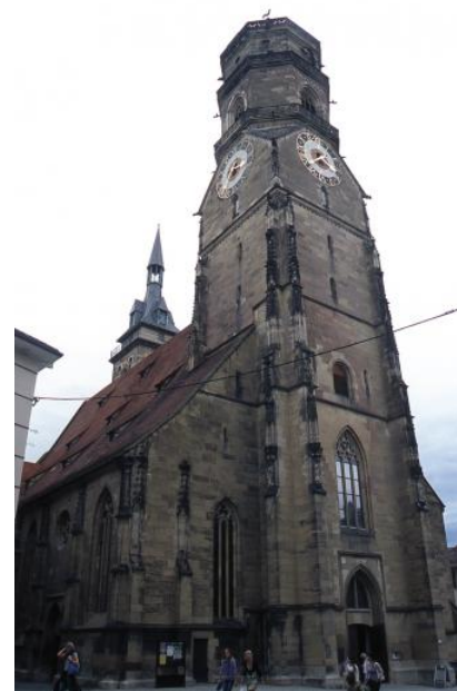
Die gotische Stiftskirche in Stuttgart aus Stuttgarter Schilfsandstein
