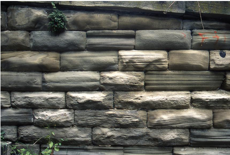
Treppenmauer an der Karlshöhe aus Stuttgarter Schilfsandstein
