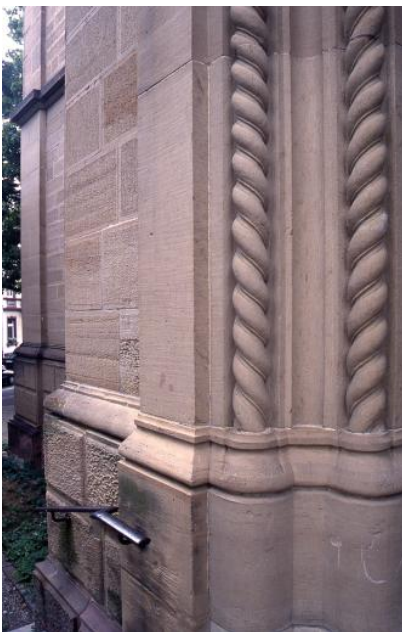
Christuskirche in Freiburg-Wiehre aus Mühlbacher Sandstein
