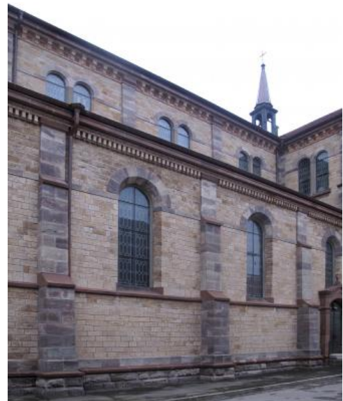
Katholische Stadtkirche in Bräunlingen: Das gelblich graue Bruchsteinmauerwerk besteht aus Marbach-Oolith
