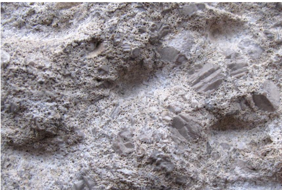
Katholische Stadtkirche in Bräunlingen: Detailaufnahme des großteils aus Marbach-Oolith bestehenden Bruchsteinmauerwerks
