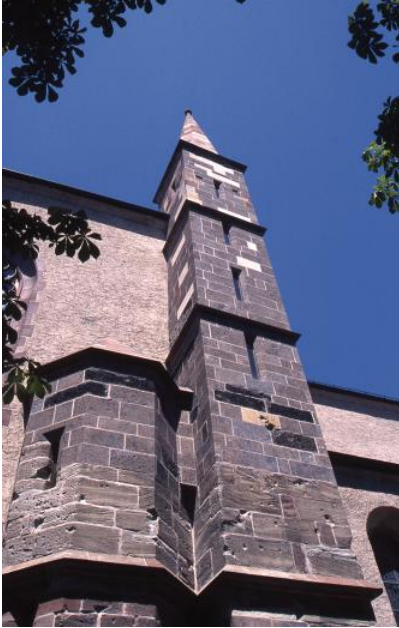
Treppenturm des Breisacher Münsters
